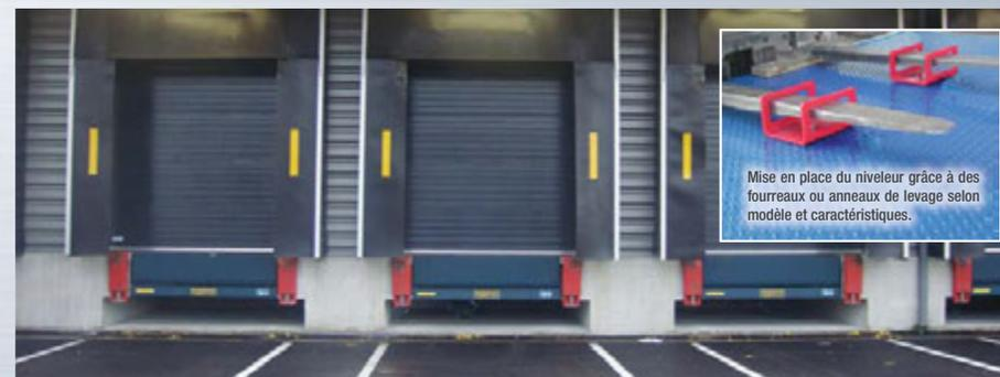
Mise en place du niveleur grâce à des fourreaux ou anneaux de levage selon modèle et caractéristiques.
