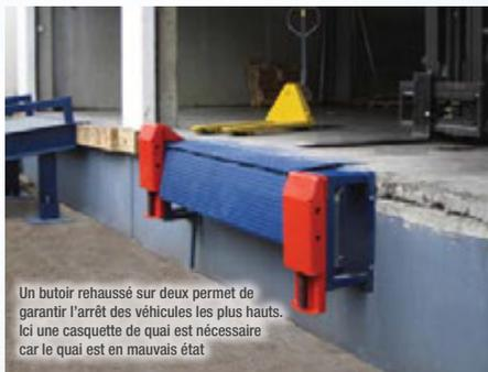
Un butoir rehaussé sur deux permet de garantir l'arrêt des véhicules les plus hauts. Ici une casquette de quai est nécessaire car le quai est en mauvais état
