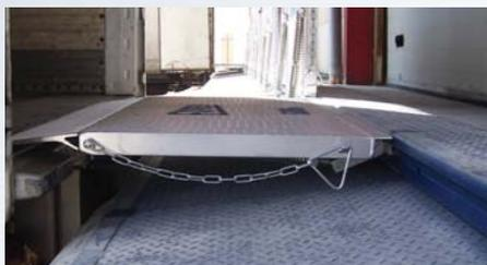
Dans le cas d'un quai en construction : la création d'un glacis (comme sur la photo ci-contre) offre bien des avantages : le rail est en retrait de l'aplomb du quai, il n'y a pas de danger de chute dans le vide pour l'utilisateur en cas de faux-pas. De plus, le pont et le rail sont protégés en cas de mauvaise manœuvre du véhicule.
